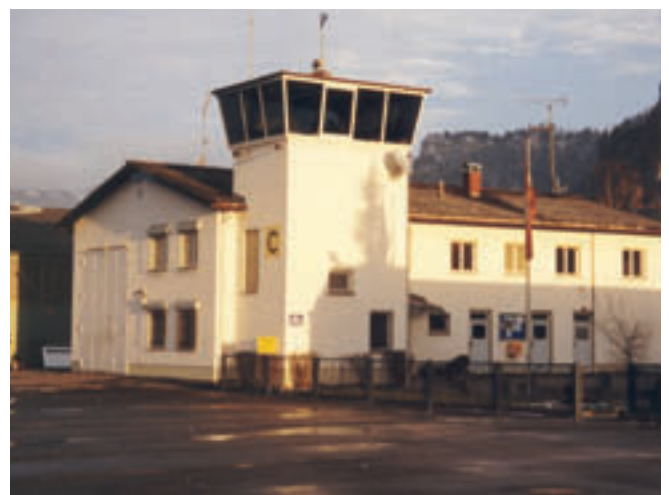
Das alte Gebäude der Flugeinsatzstelle Hohenems wurde 2004 abgerissen und durch einen modernen Bau ersetzt.
