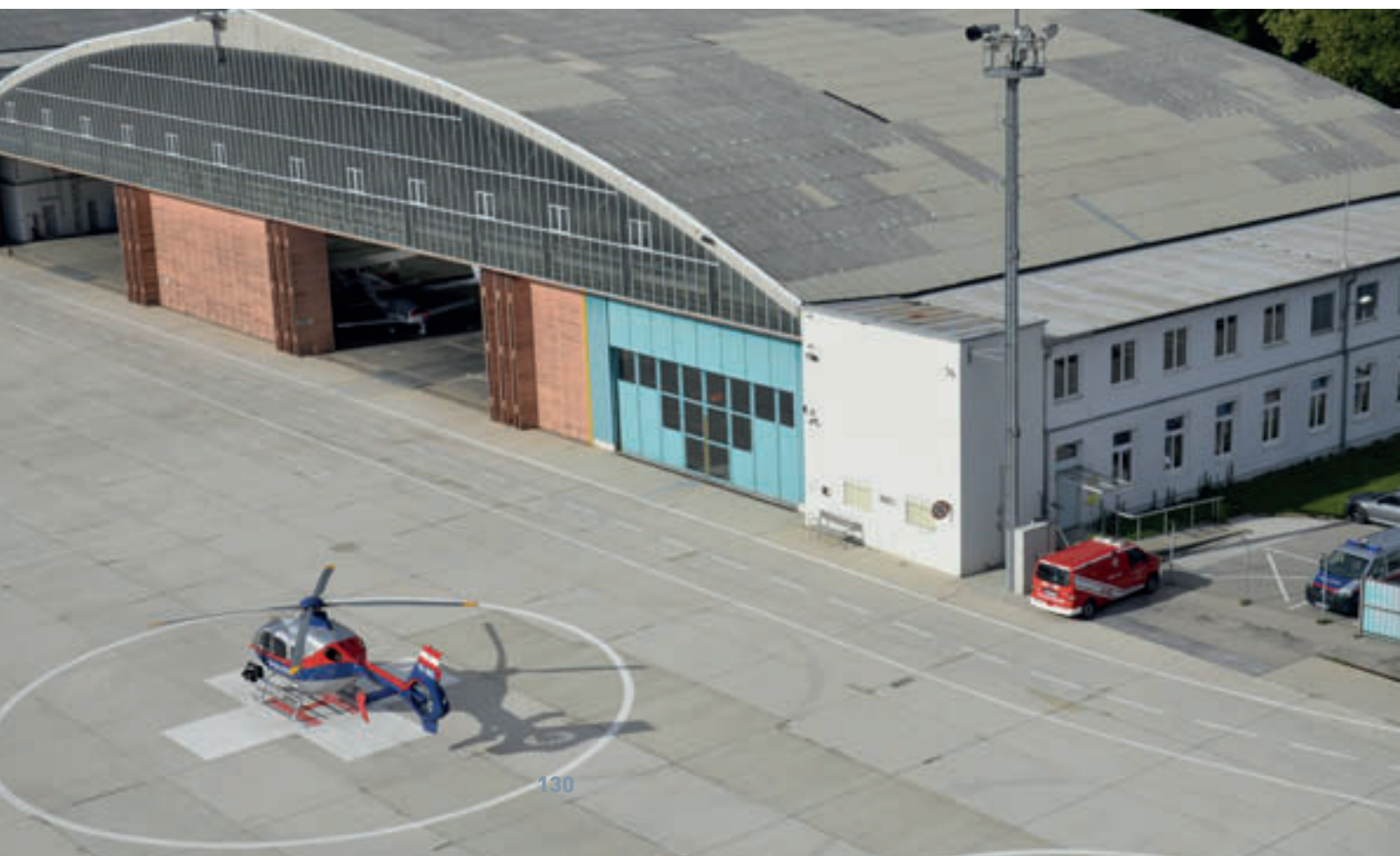
Ansicht der Flugeinsatzstelle Klagenfurt von oben
